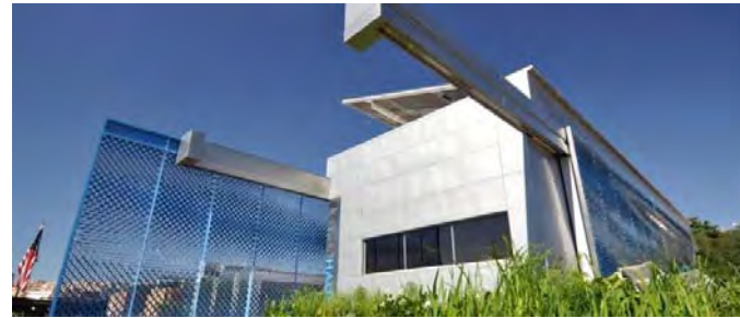
Forschungsinstitut für Wärmeschutz e.V. München | Lochhamer Schlag 4 | 82166 Gräfelfing
